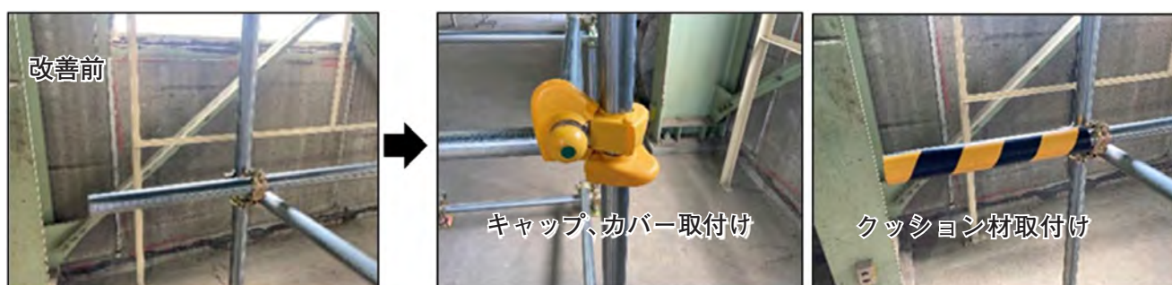
写真3 安全カバー、キャップ、クッション材 設置状況
