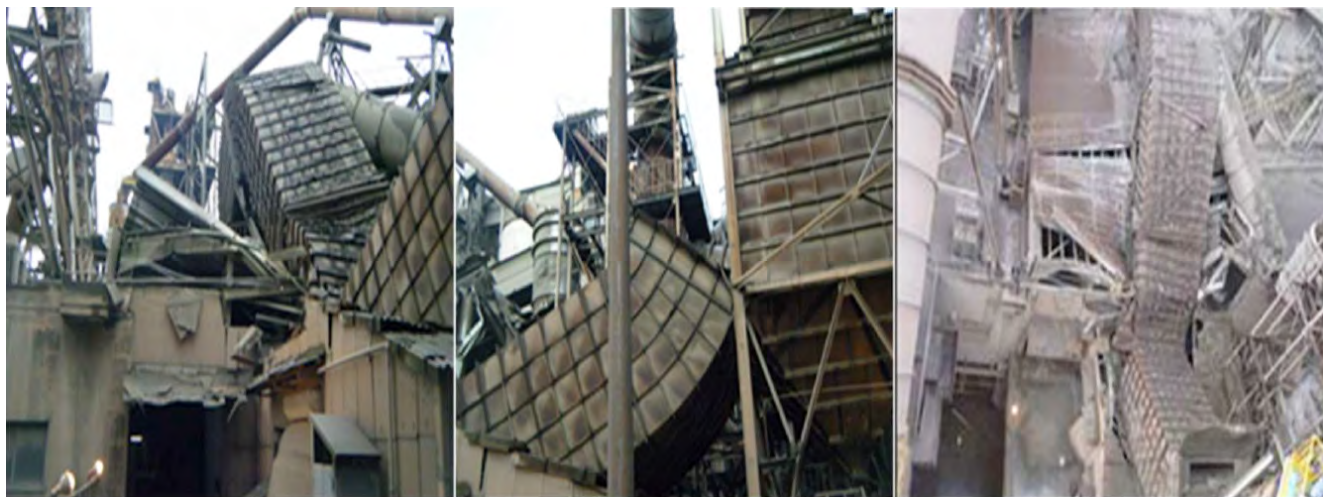
写真 1 崩落したダクト
