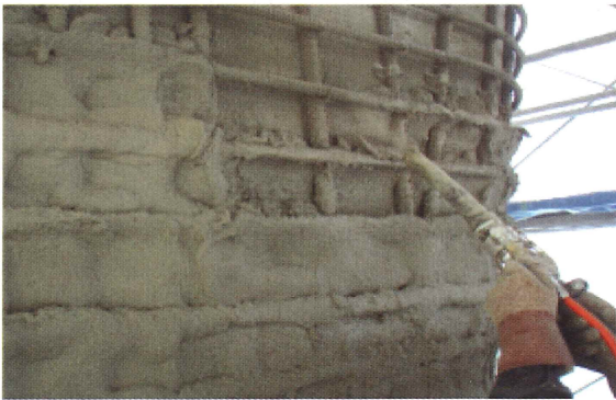
写真-1 吹付け状況
