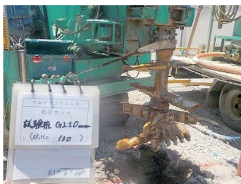
写真 1 攪拌翼および共回り防止翼
